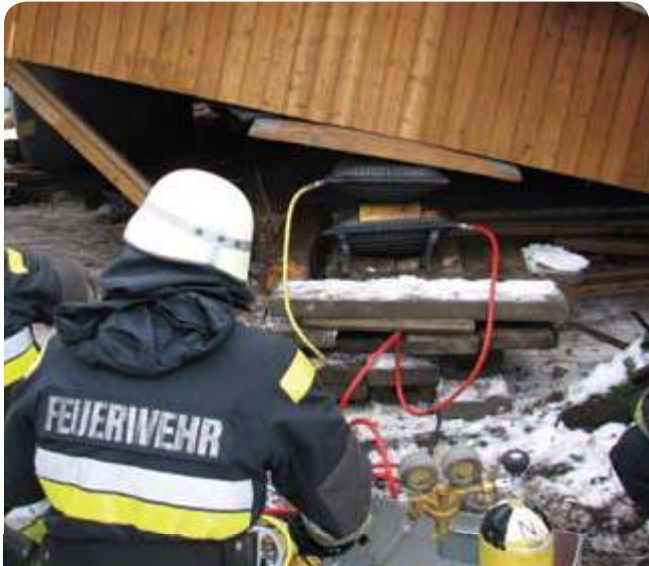
Работа двух пневмодомкратов вместе.
